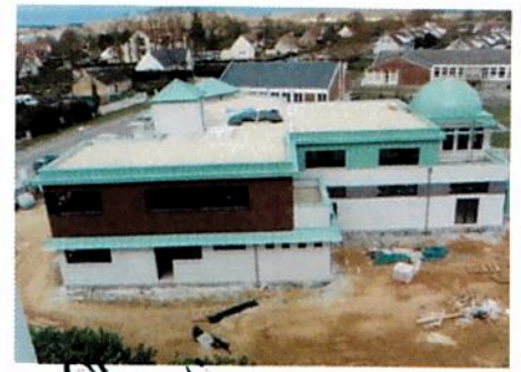
Chantier en cours
